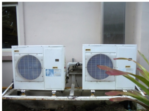
ภาพที่ 3-35 เครื่องปรับอากาศ แบบ Split Type ประหยัดพลังงาน
