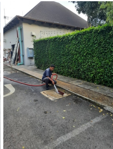
ภาพที่ 3-45 ล้างทำความสะอาดท่อระบายน้ำ ให้การระบายน้ำดี ไม่มีขยะอุดตัน
