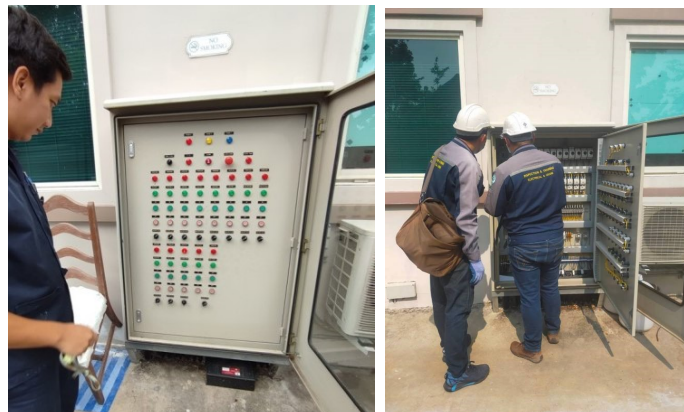
ภาพที่ 3-11 แยกมอเตอร์แผงควบคุมระบบบำบัดน้ำเสียโดยเฉพาะ ตรวจสอบและบำรุงรักษาอย่างสม่ำเสมอ
