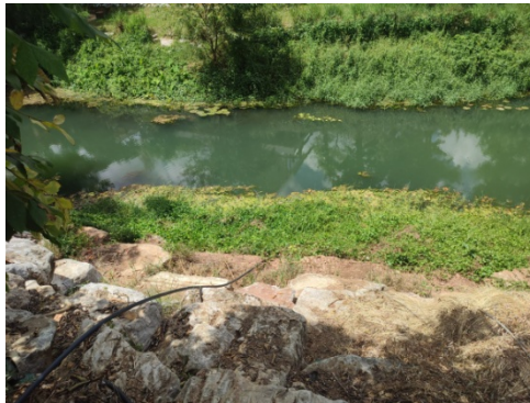
ภาพที่ 3-2 กำแพงดินเป็นภูเขารธรรมชาติ ใช้หินอ่อนตัดก้อน ทำเป็นกำแพงดินมีความลาดเอียงไม่เกิน 45 องศา และบ่อพักน้ำก่อนระบายออก
