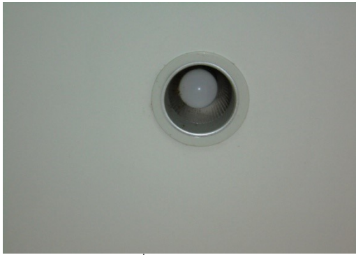
ภาพที่ 3-33 โคมไฟมีแผ่นสะท้อนแสงและ หลอดไฟเป็นแบบประหยัดพลังงาน (LED)
