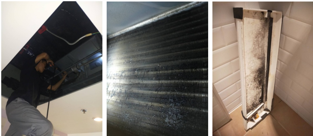
ภาพที่ 3-41 ล้างทำความสะอาดเครื่องปรับอากาศ
