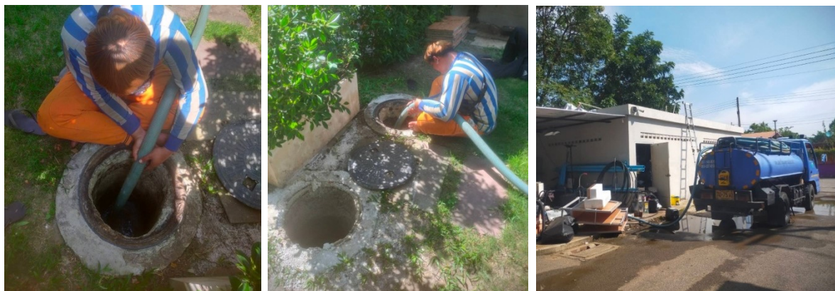
ภาพที่ 3-10 สูบตะกอนไขมันออกจากถังแยกตะกอน
